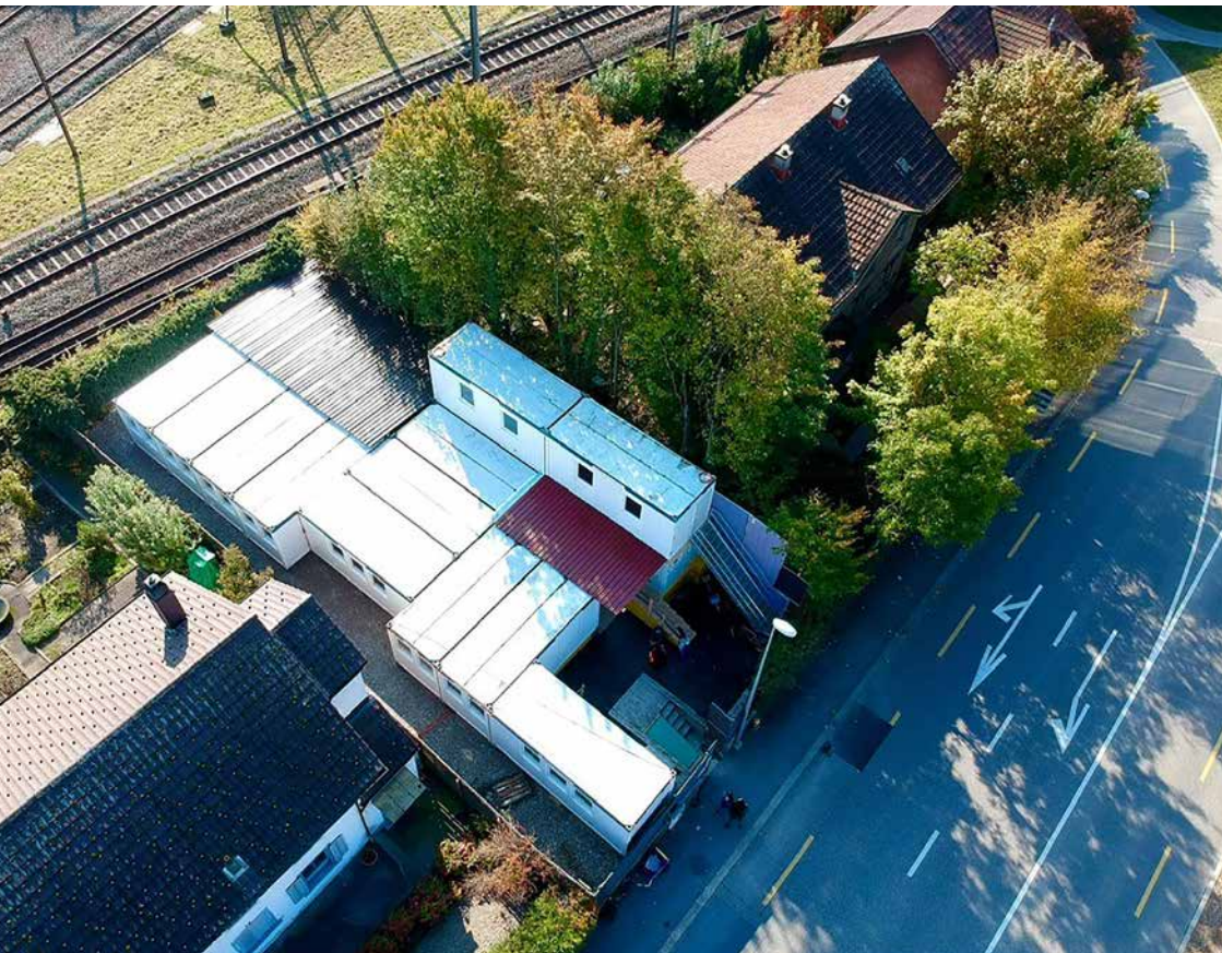
Porovisorischer Standort der Kontakt- und Anlaufstelle an der Dornacherstrasse 10 in Solothurn.
